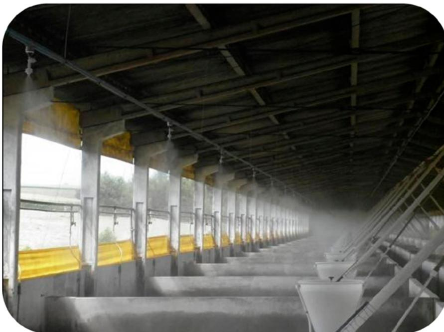
**Figura 10** – Sistema de umidificação do ambiente por nebulização - <http://irrigasulsh.com.br/nebulizacao>
